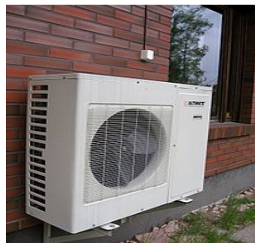
Рис. 2. Повітряний тепловий насос
